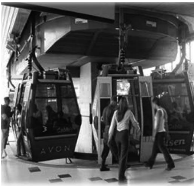
Imagen 5 y 6. Estructuras de soporte y Estaciones de Acceso
