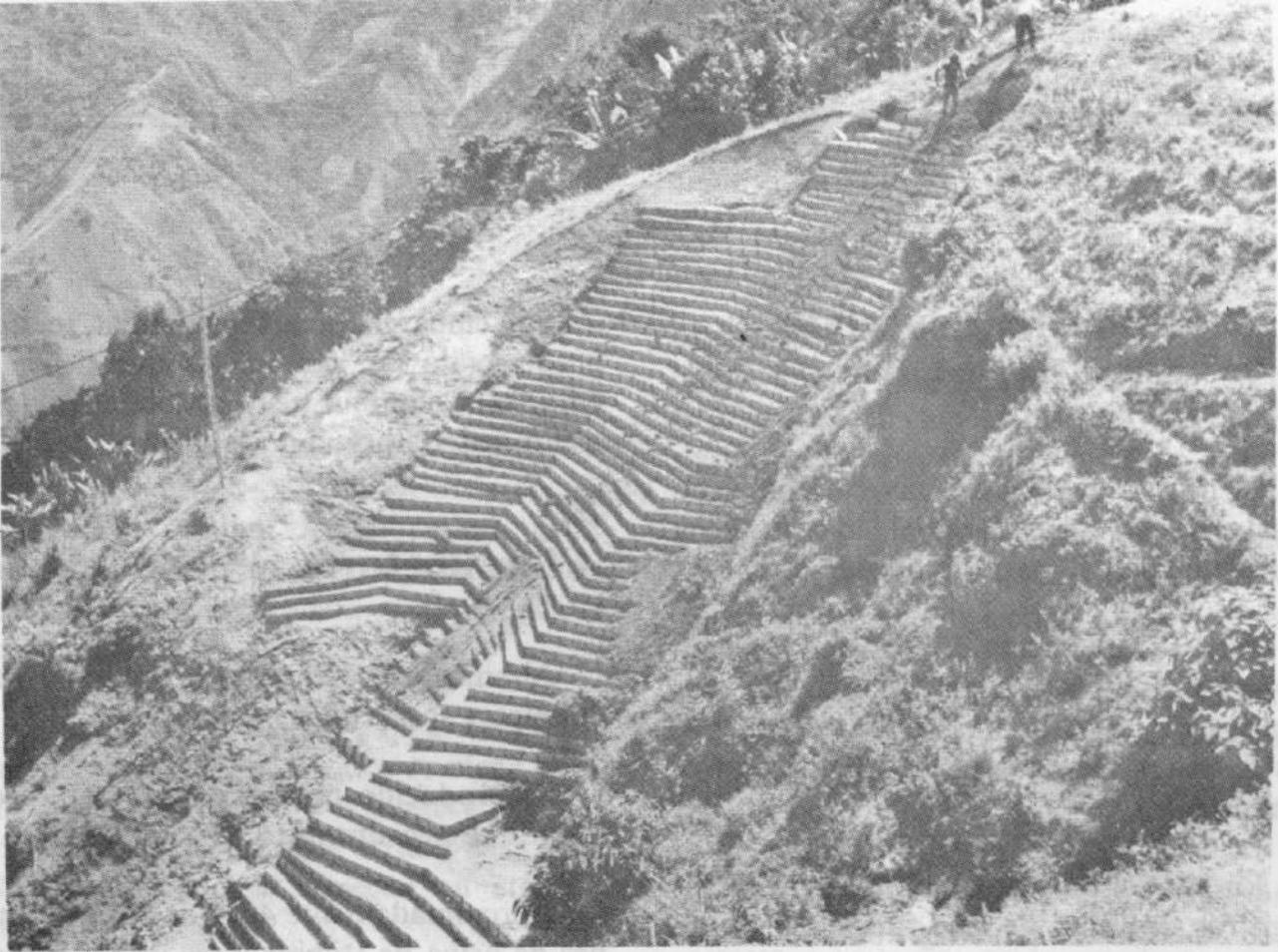
**FIGURA 1.** Recuperación de cárcavas con trinchos en esterilla, Municipio de Salamina, Departamento de Caldas Corporación Regional Autónoma.
