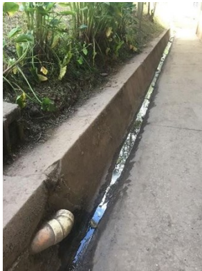
Figura 8. Canal Agua Lluvia
