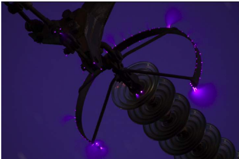
Figura 1. Anillo anticorona en una línea de 500 kV
