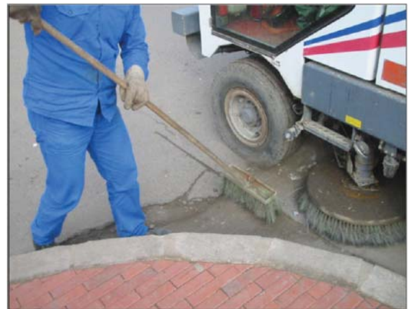
Fig. 4. Barrido manual y mecánico.
