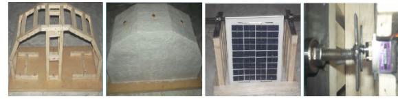
Figura 5. Detalles del proceso de construcción.
